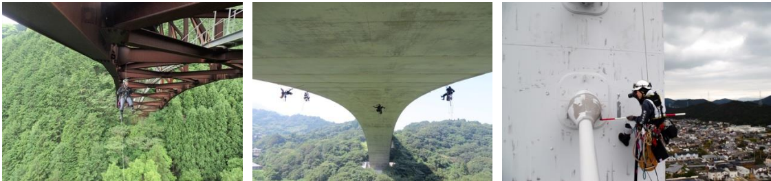
特殊高所技術を用いた橋梁点検の様子
