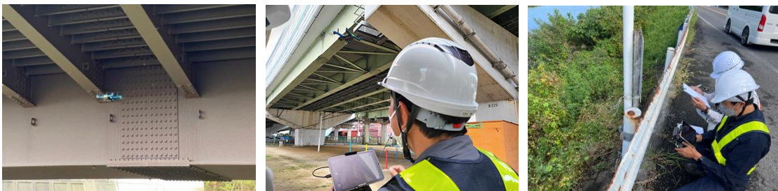
ドローンを用いて遠隔から橋梁点検を実施している様子
