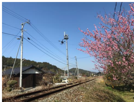
鉄道施設点検状況
