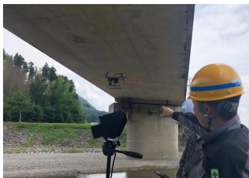
鉄道施設点検状況
